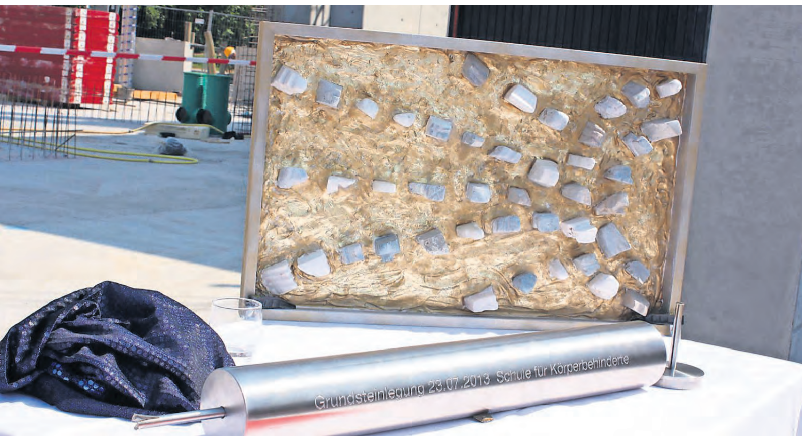
Ein feierlicher Anlass: Am 23. Juli dieses Jahres wurde der Grundstein für den Neu- und Erweiterungsbau der Schule für Körperbehinderte in Stuttgart-Möhringen gelegt. Vertreter aller an der Planung beteiligten Stellen waren anwesend. FOTOS: STADT STUTTGART
